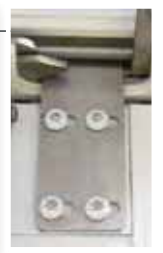
Vérouillage mécanique du portillon dès que la porte de garage s'ouvre
