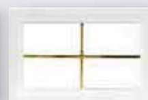
n° 7 — Croisillon laiton intégré dans le vitrage
