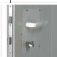
Vérouillage intérieur sans clé (bouton moleté)
